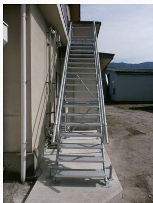
老朽化した外階段をリノベーション
