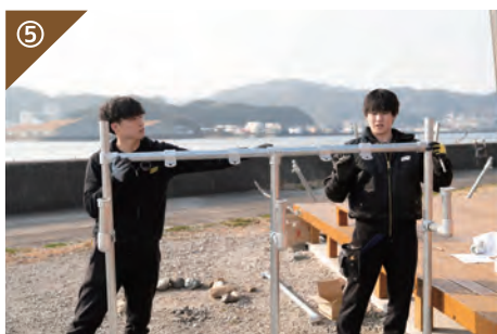
⑤ カウンター部分のフレーム組み上げ
