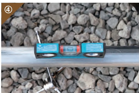
④ 水平調整金具で水平出し
