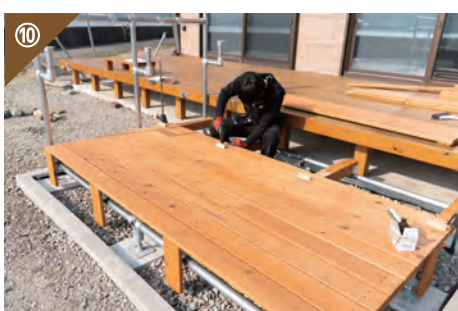
⑩ 床板が割れないように面取も忘れず
