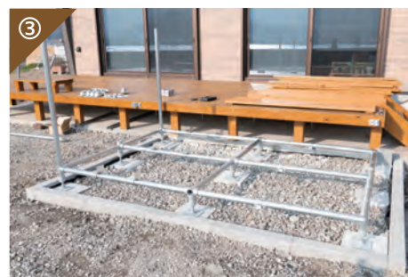
③ 基礎フレーム完成
