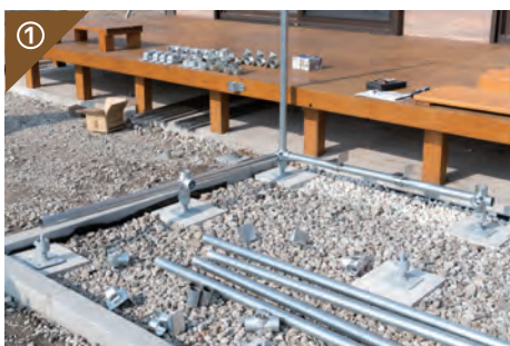
① 基礎フレームを組み上げ
