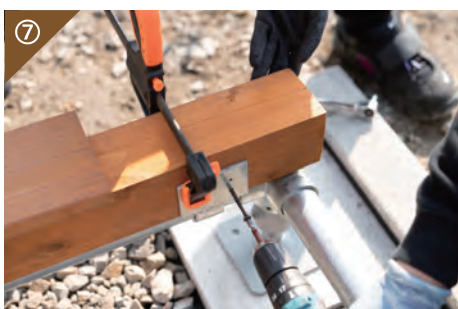
⑦ 大引を木材留め金具に固定
