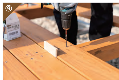
⑨ スペースを挟みつつ床板を固定
