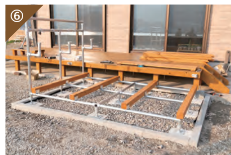
⑥ 大引を設置して留め金具の位置調整
